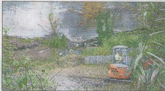
Am Arbeiten unterhalb der eindrücklichen Gysnauflühe.
